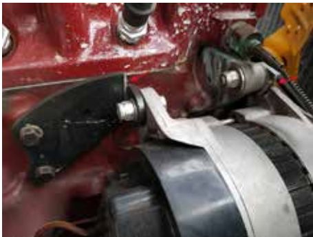
De trasiga generatorfästena.
